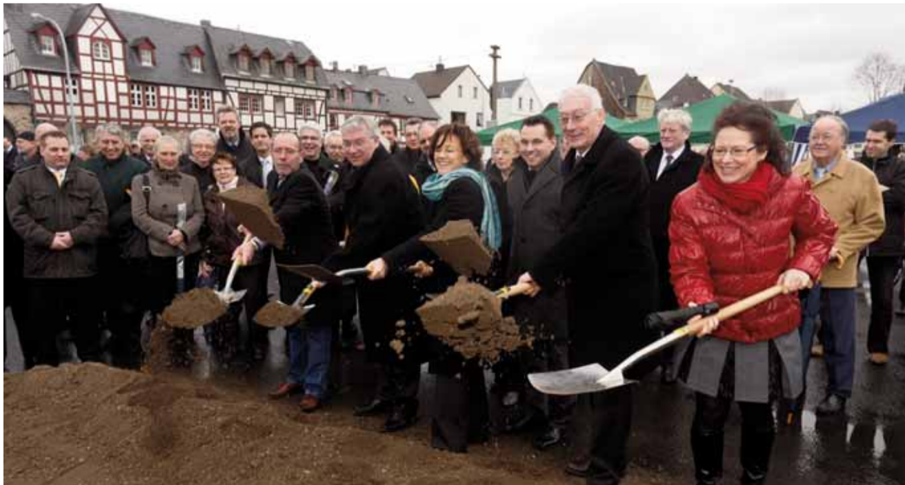
Die neue Hochwasserschutzmaßnahme in Koblenz umfasst sieben Bauabschnitte und wird für 41 Millionen Euro bis Mitte 2014 realisiert. Mit dem ersten Spatenstich gab Umweltministerin Margit Conrad jetzt den Startschuss für das Projekt. Foto: Thomas Frey
